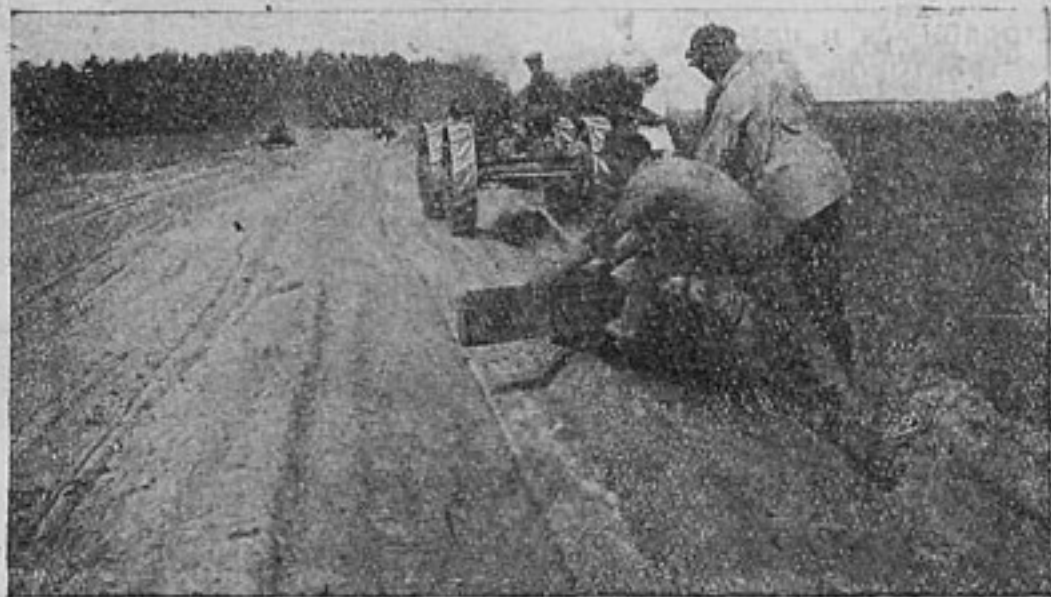
Канавокопатель с колесным трактором «Павези», мощностью в 22 лш. силы, делает четвертый проход для полного профиля треугольного лотка
