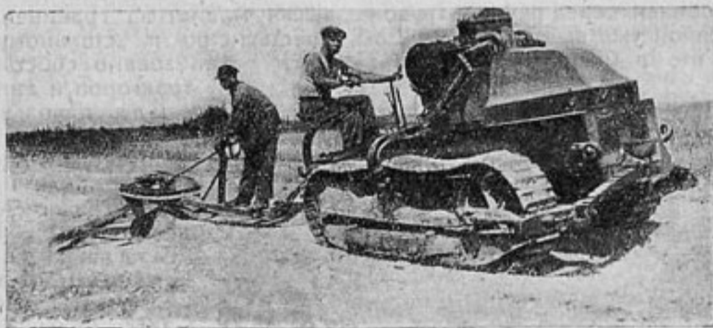
Трактор „Рено“ мощностью в 25 лш. сил с пленом разравнивает передвинутую землю (Ленинградская область)
